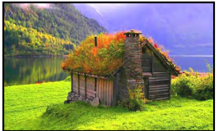
Sod Roof on Hytte in Høsten
